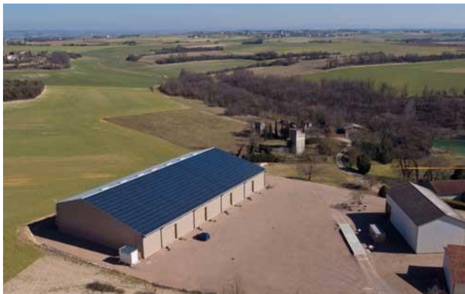
Amarenco va implanter des microcentrales solaires sur les toits de hangars agricoles (photo : Amarenco)
